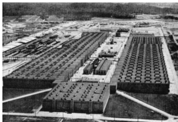
Америчка фабрика за обогаћивање на принципу ефузије
